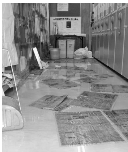
地下・化学文献室での水漏れ
