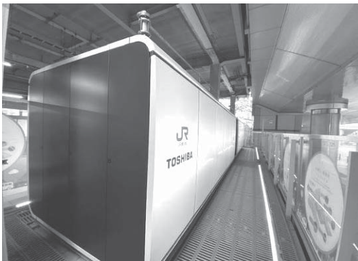
写真1 トラック3台分くらいのコンテナが並んでいる
