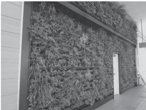
写真4 壁面緑化で空間を演出
