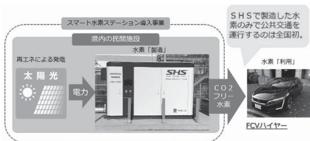
図2 神奈川県再エネ水素ステーション
